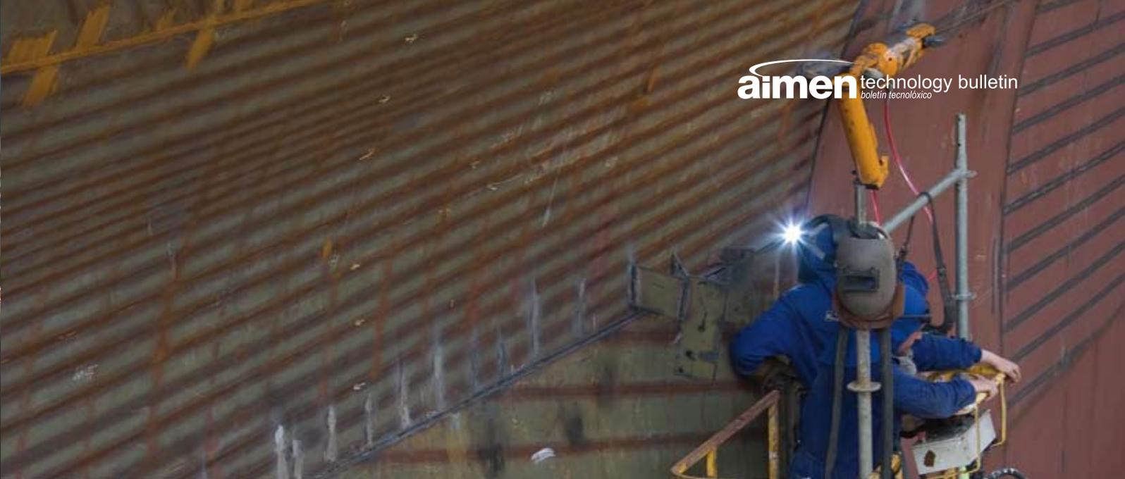
y a los espesores del material utilizado. Los parámetros de mayor influencia en el proceso son: la potencia láser, la posición focal del haz, la velocidad de soldeo, el gas de proceso empleado, las características del hilo de aporte (composición, diámetro, forma), la potencia suministrada al arco, la longitud del arco, el ángulo relativo haz láser/antorcha, la separación haz láser/antorcha (offset) y la posición relativa respecto a la dirección de soldadura.
